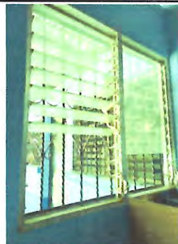
Foto 2: Sustrucción de ventanas; sistema de apertura: Corredizas, Perfiles color blanco estandar, Material del marco: PVC Material de la ventana: Vidrio, sellado perimetral.
