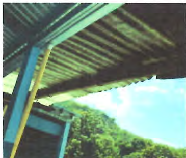
Foto1: Sustrucción de cubierta de techo con lámina galvanizada, Tipo de lamina: troquelada Calibre: 26, incluye: fijaciones y sellado en traslapes.
